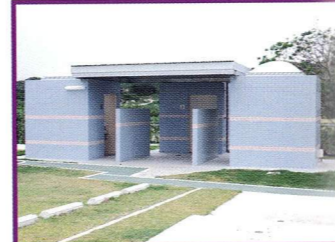
バリアフリー対応のトイレ完備。
