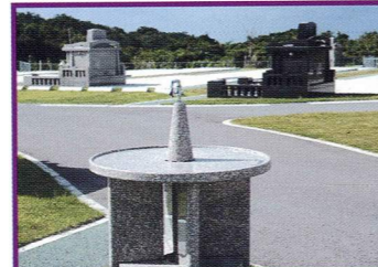
園内11箇所に洗場を設置。
